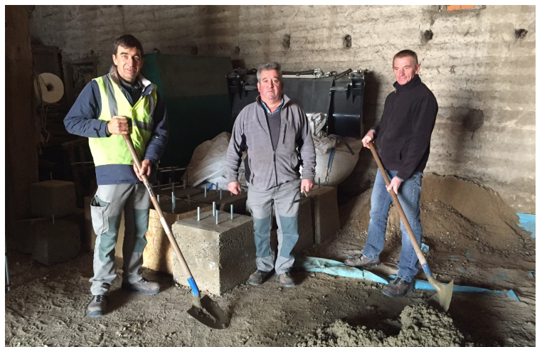
Réalisation et pose de plots béton pour la fixation des jeux pour enfants en cours d'installation (Bruno, Pascal et Laurent)
