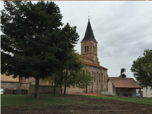
Démolition du mur de la place du centre bourg pour une meilleure visibilité du marché du jeudi matin
