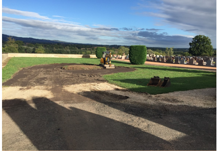
Aménagement d'une aire de retournement au cimetière pour en sécuriser la sortie
