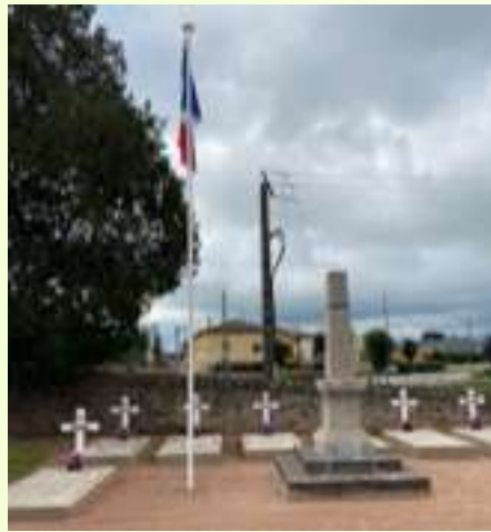
Carré militaire: Installation d'un mât de pavoisement permanent
