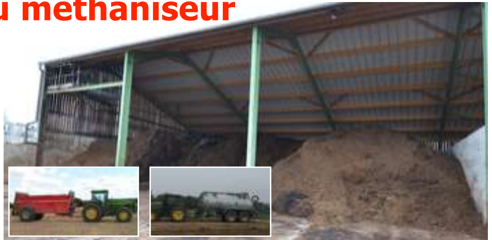
Exemple d'ouvrage similaire, de plus faible capacité, de stockage de digestat (Mauges-sur-Loire près d'Angers)
